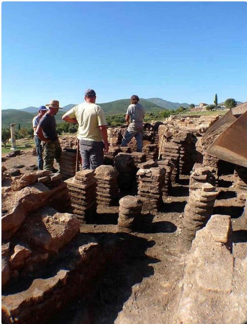
Työmiehet kaivavat esiin Antiikin Messiniassa kylpylän "tulipesän" mustuneita raunoita.
