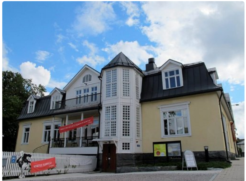
Pukstaavi sijaitsee peruskorjatussa entisen apteekkari O. A. Bäckmanin talossa.
