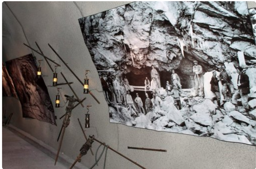
Rakennusolosuhteet 1900-luvun alkupuolella olivat haasteelliset. Valokuvat käytävillä kertovat työmenetelmistä.
