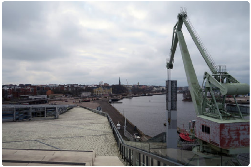
Merikeskus Vellamon kattoterassilta on upea näkymä Kotkan Kantasatamaan. Oikealla alapuolella jäänmurtaja Tarmo odottelee kesäviearaitaan.
