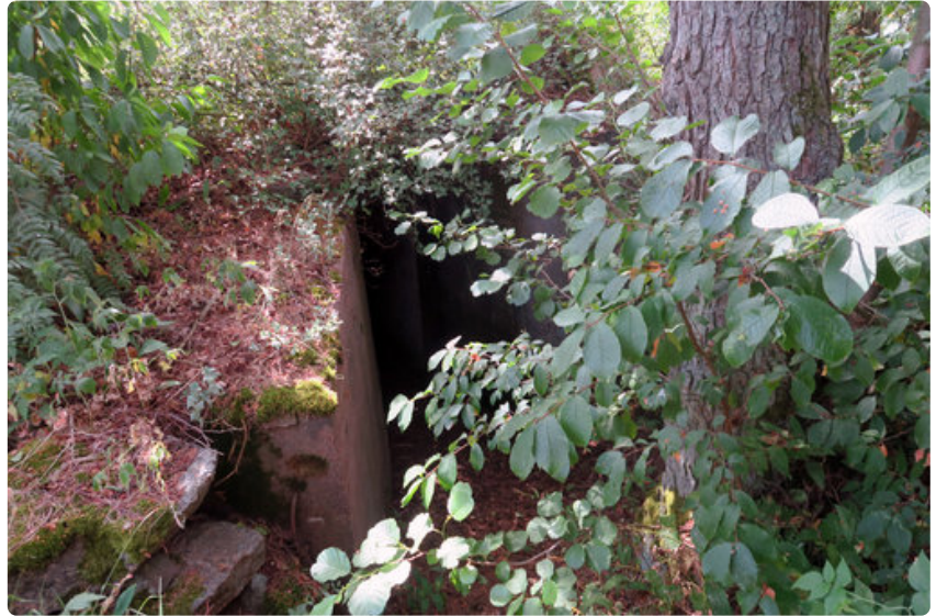
Ulko-Tammiossa on korsuja ja muita sodassa tarvittuja rakennelmia.
