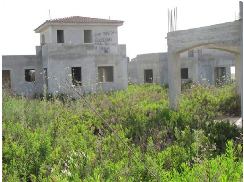
Upealla paikalla rannan tuntumassa sijaitseva 10 luksustalon rakennustyömaa on pysähtynyt laman myötä.
