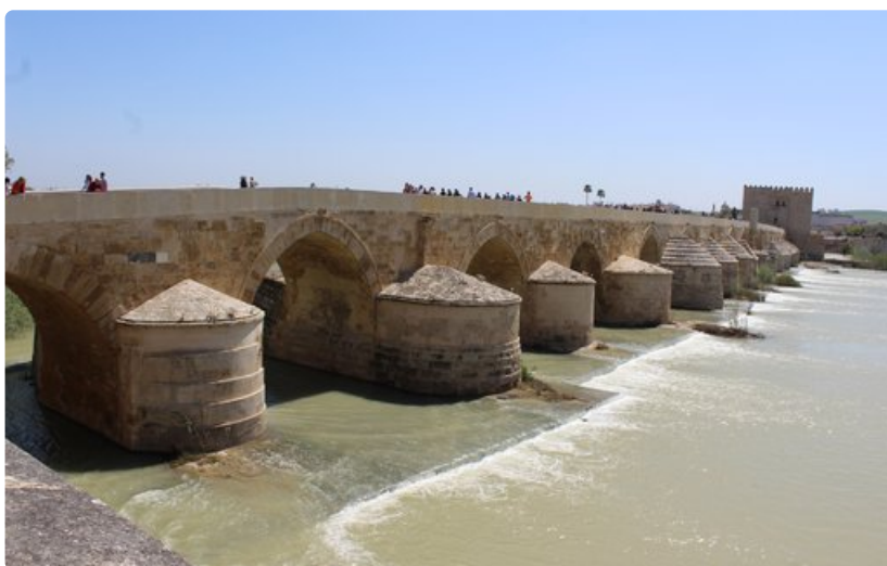
Roomalainen silta on toiminut yli 2 000 vuotta.
