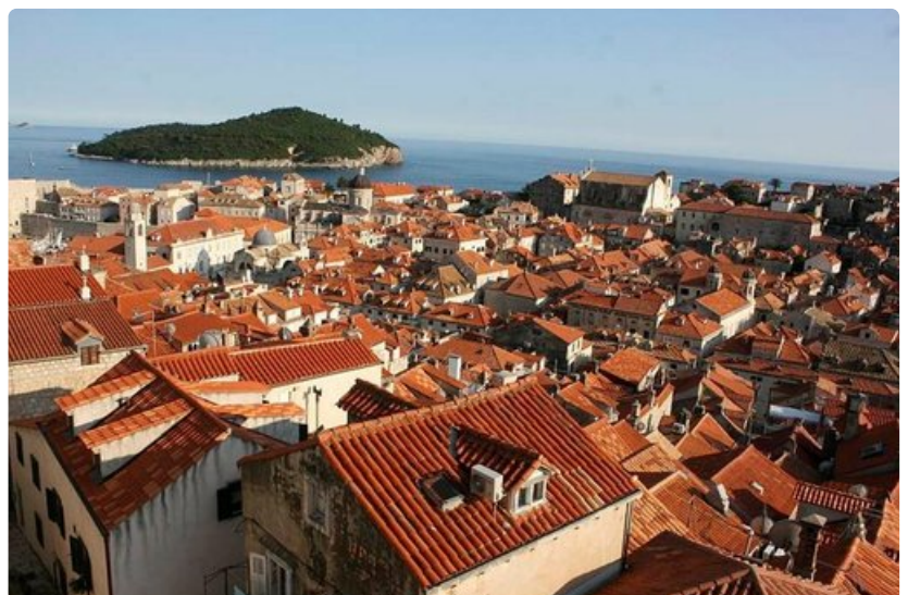
Vanhankaupungin punaiset tiilikatot vaurioituivat sodan aikana 1990-luvulla
