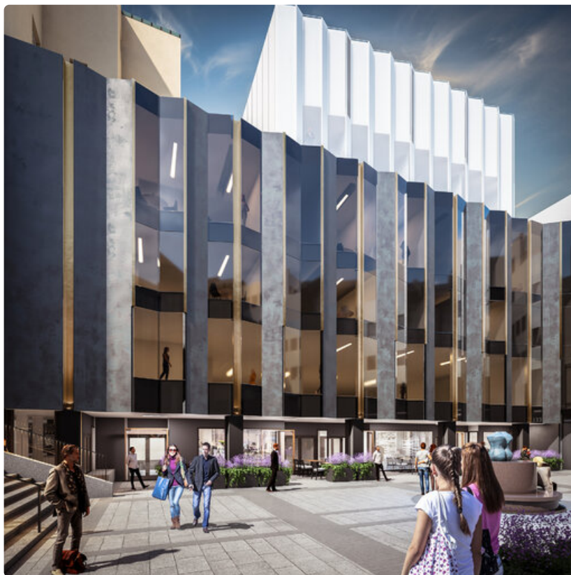
Grand Hansa -hotellin julkisivu Kaivopihalta katsottuna.
