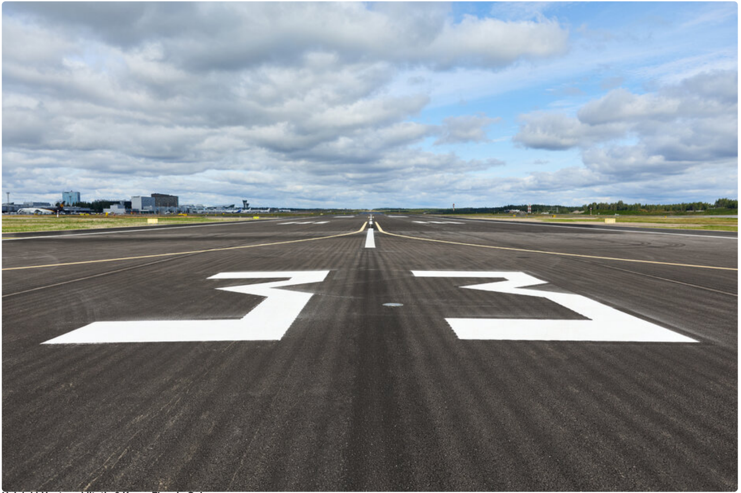
Helsinki-Vantaan kiitotie 2.Kuva: Finavia Oyj
