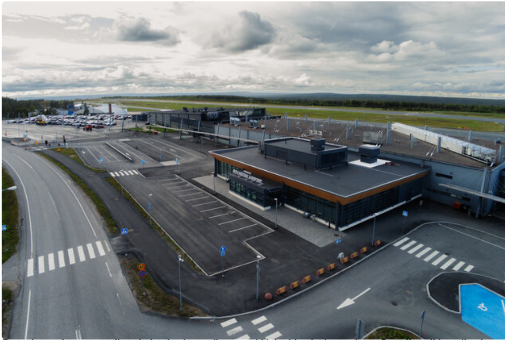
Rovaniemen lentoasemalla valmistui syksyn aikana parkkialueiden laajentaminen. Samalla selkiytettiin ajoneuvokohtaisia parkkialueita. Kuva Finavia.
