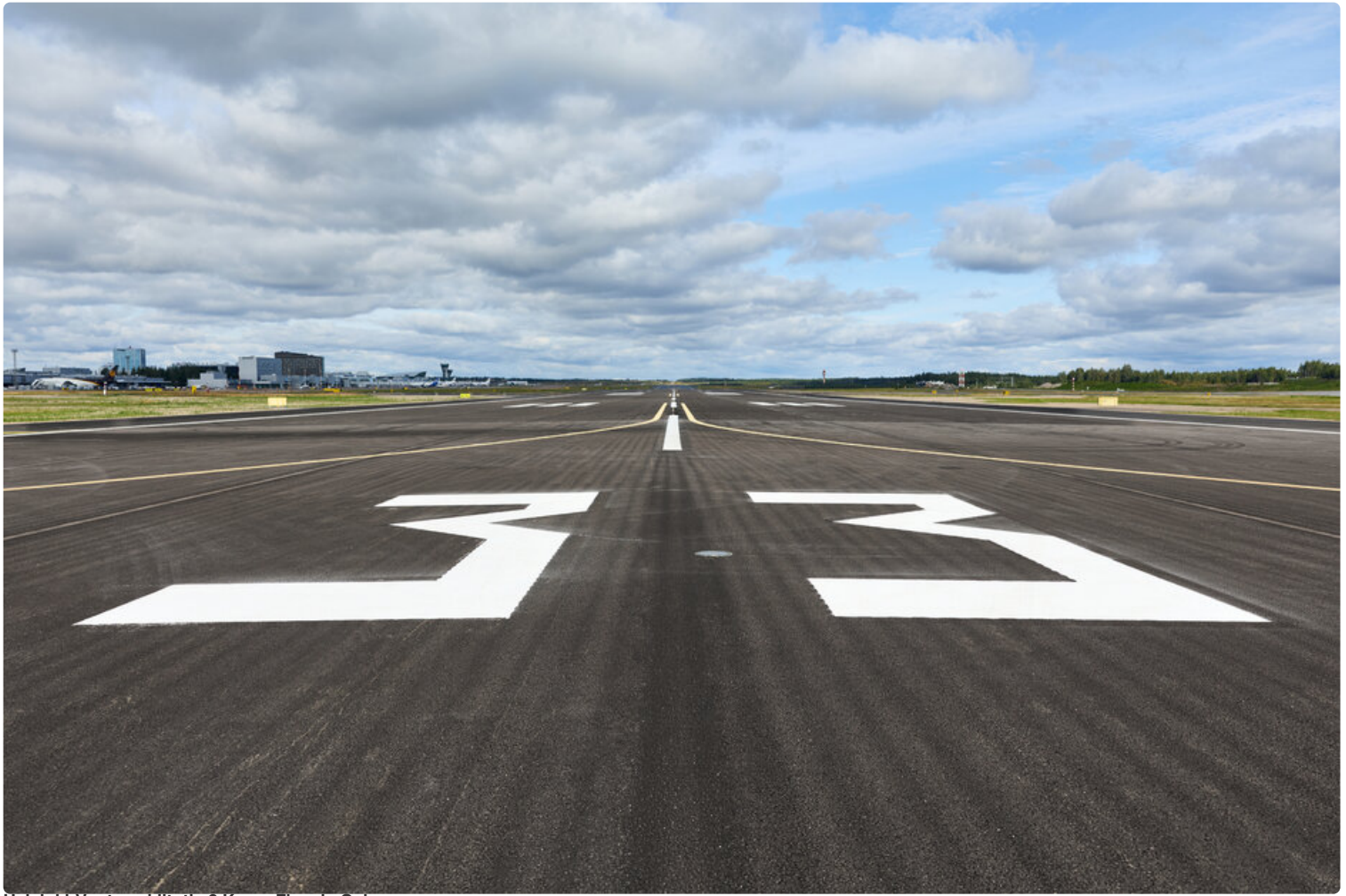
Helsinki-Vantaan kiitotie 2.Kuva: Finavia Oyj
