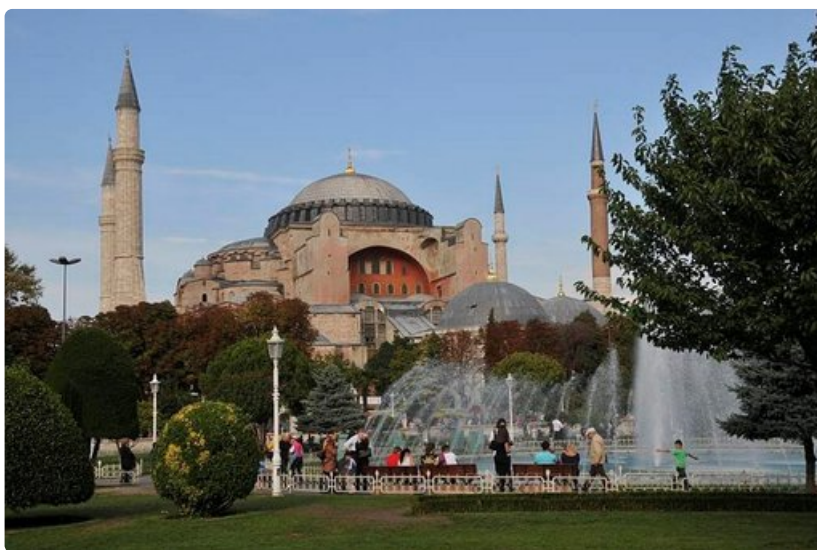
Maanjäristyksistä huolimatta Hagia Sofia seisoo tukevasti paikoillaan.
