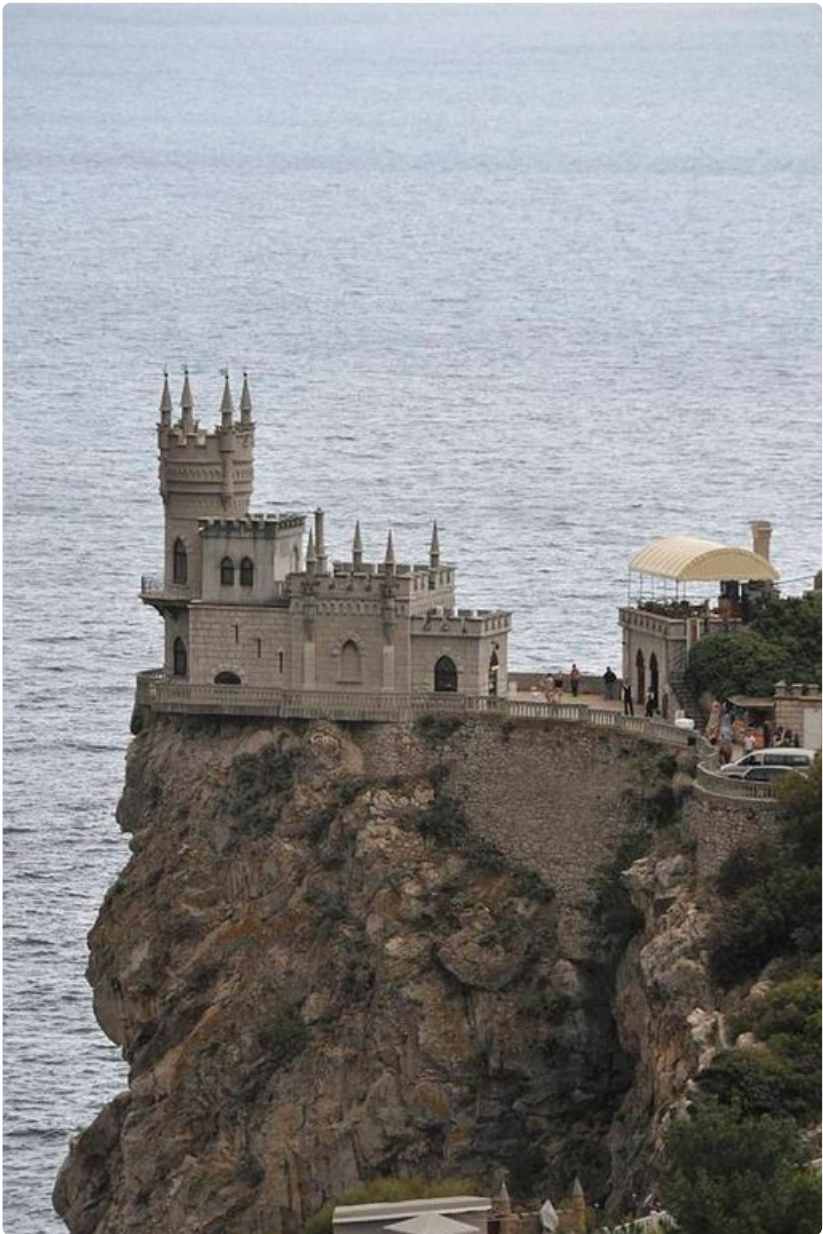
Pääskysenpesä on yksityislinna, johon liittyy dramaattisia rakkaustarinoita.
