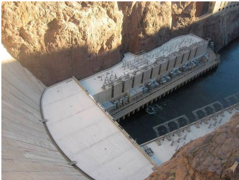
Voimalaitoskenttä on yli 200 metriä vesipinnan alapuolella.
