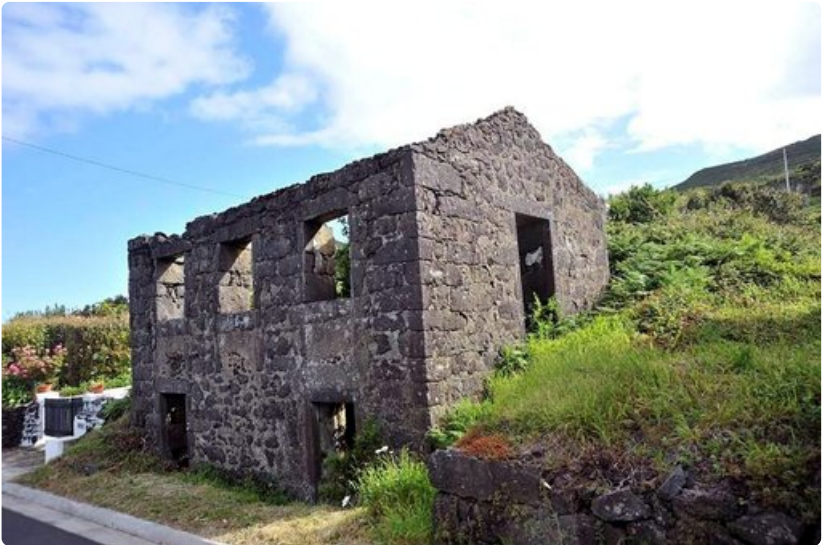
Laavan ja maan uumenista syöksyneiden kivien tuhoama rakennus.
